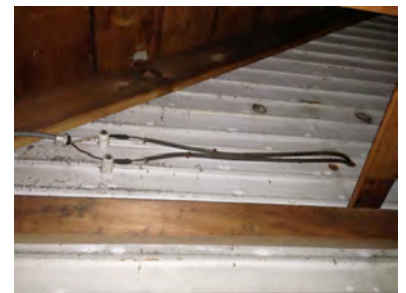
DS-11 Knob & tube wiring
